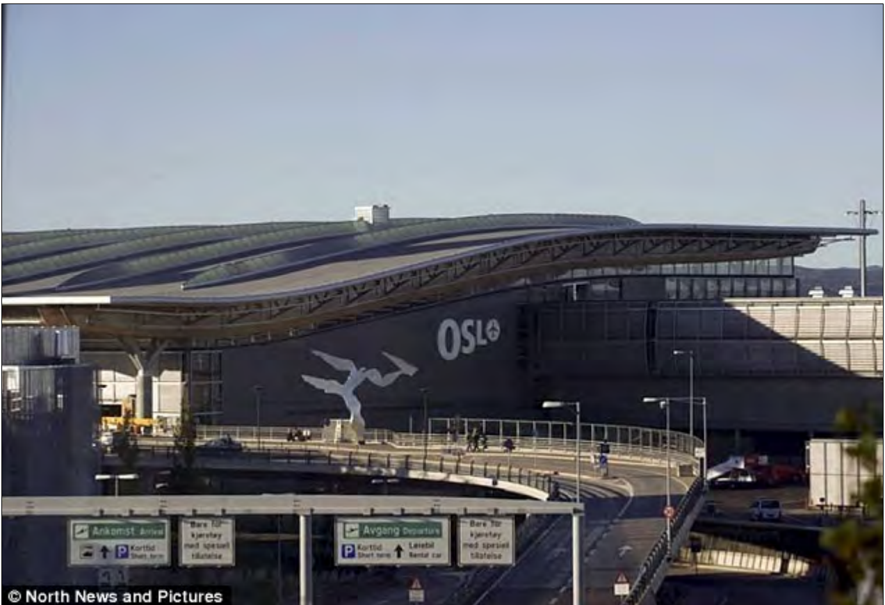
挪威上榜的机场是奥斯陆的加登莫恩机场。加登莫恩机场的2号航站楼于2008年建造，由Aviaplan建筑事务所设计，采用轻型飘浮屋顶，主要使用木料、金属和玻璃材料。 日本大阪的关西机场(6/10)
