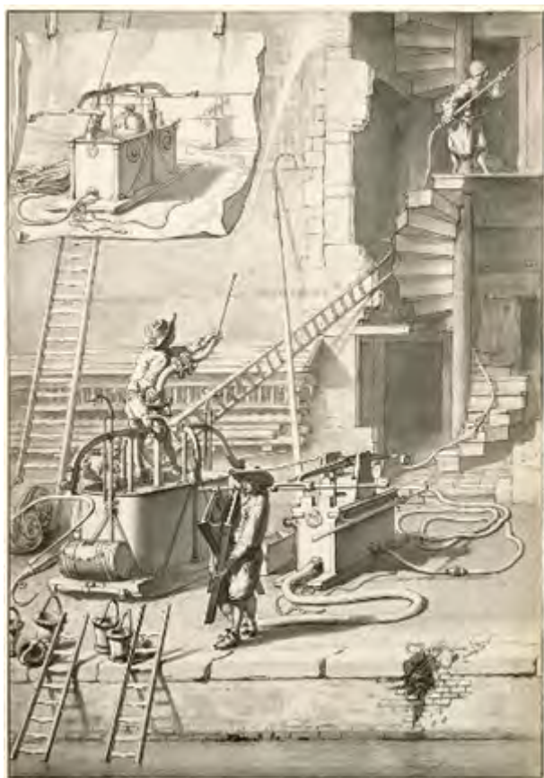
图7.德海登绘制的自制消防泵（右）与传统的消防泵（左，豪施型泵浦）之比较。
