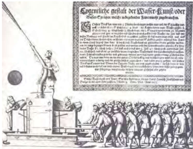
图 6. 豪施的两缸手压泵浦的特征是 28 人同时操作水平杠杆，气箱（被箱体遮盖，看不见）和橇式移动平台。
