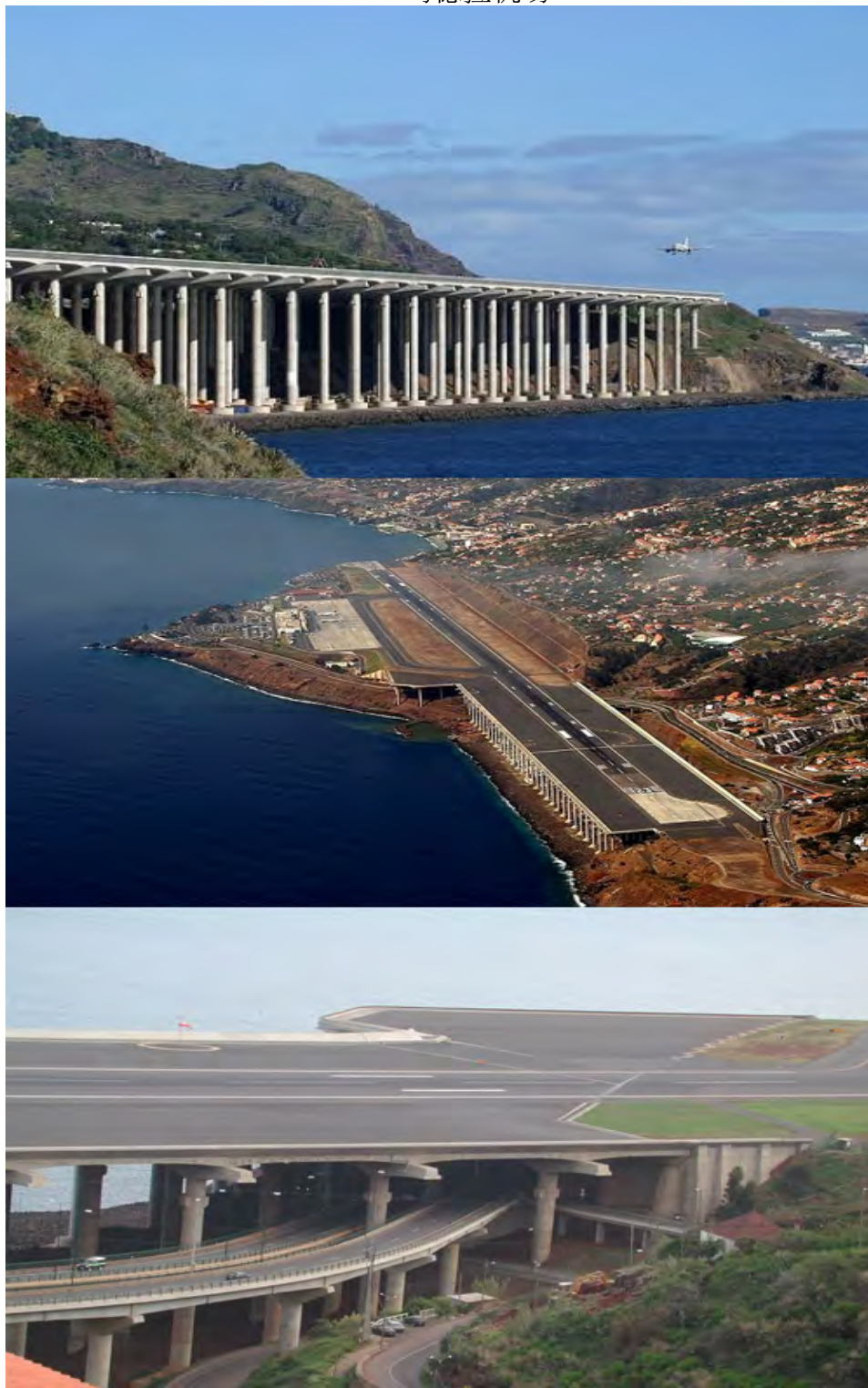
图为葡萄牙属地马德拉群岛首府，土地极其稀缺。180根柱子牢牢撑起跑道，之所以摒弃钢混填塞是桥下还可以成为巨型停车场。这么天才的作品也最终获得2004国际桥梁和结构工
