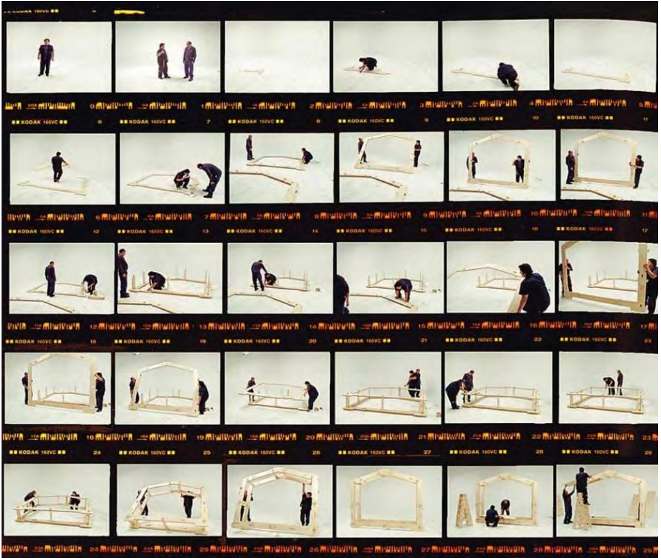
WikiHouse 的建造过程
