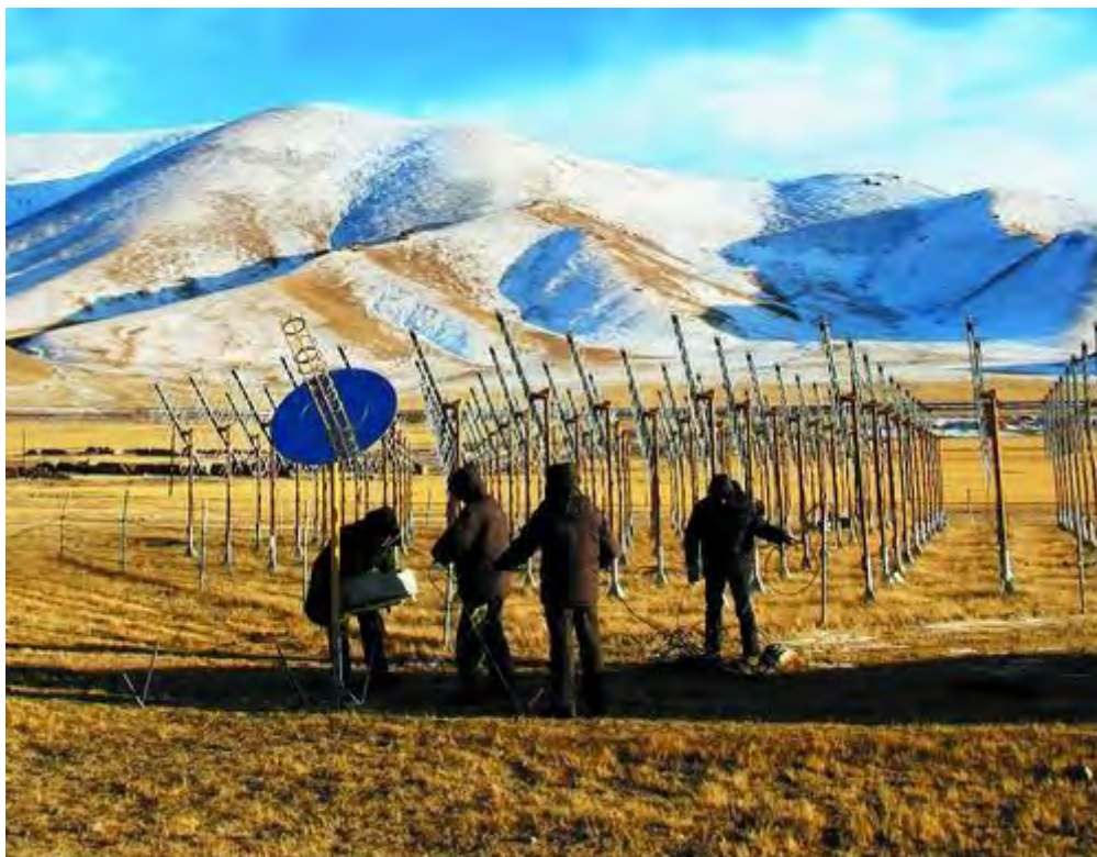
“宇宙第一缕曙光”探测工作人员在安装天线。
