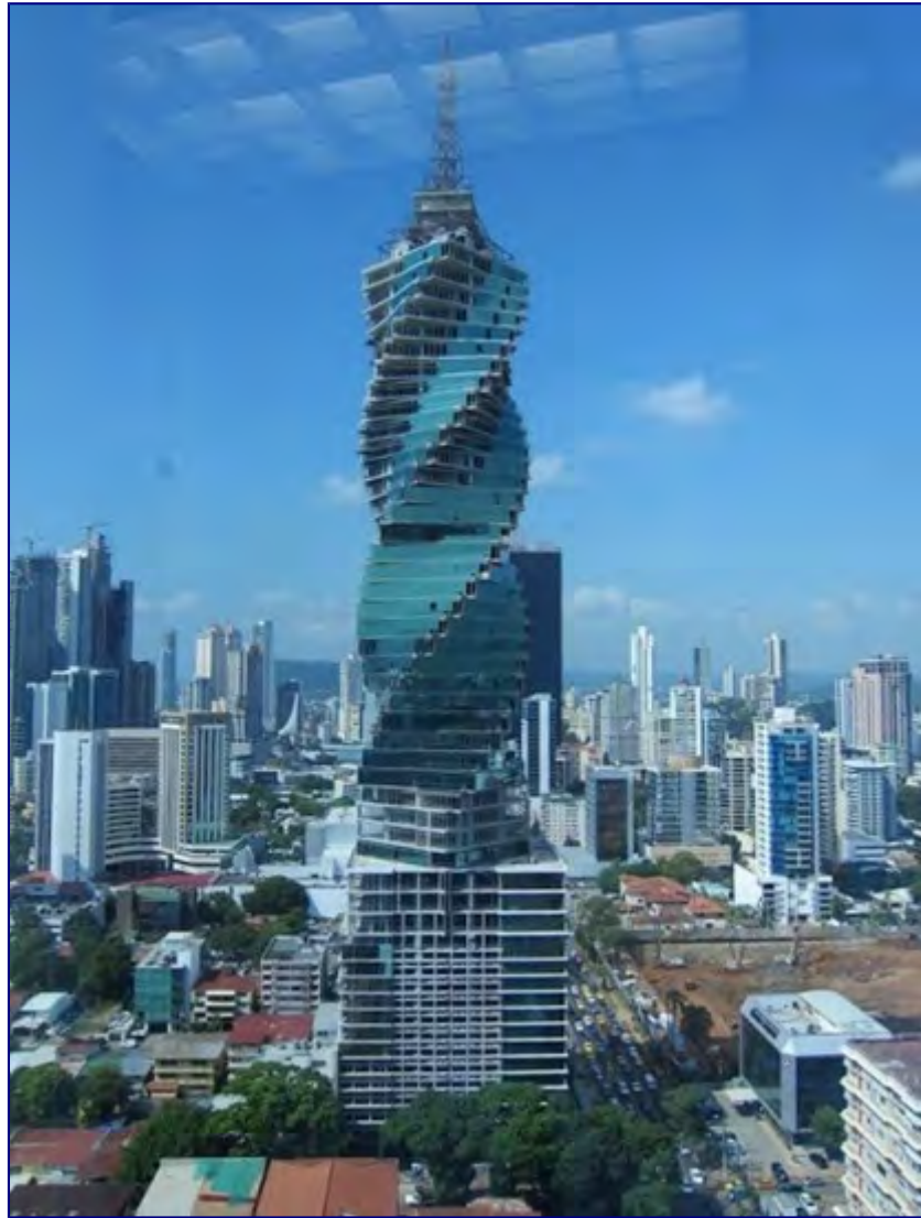
这座高 242 米，52 层的钢筋混凝土塔楼，其整体建筑相对地面扭转了 360 度
