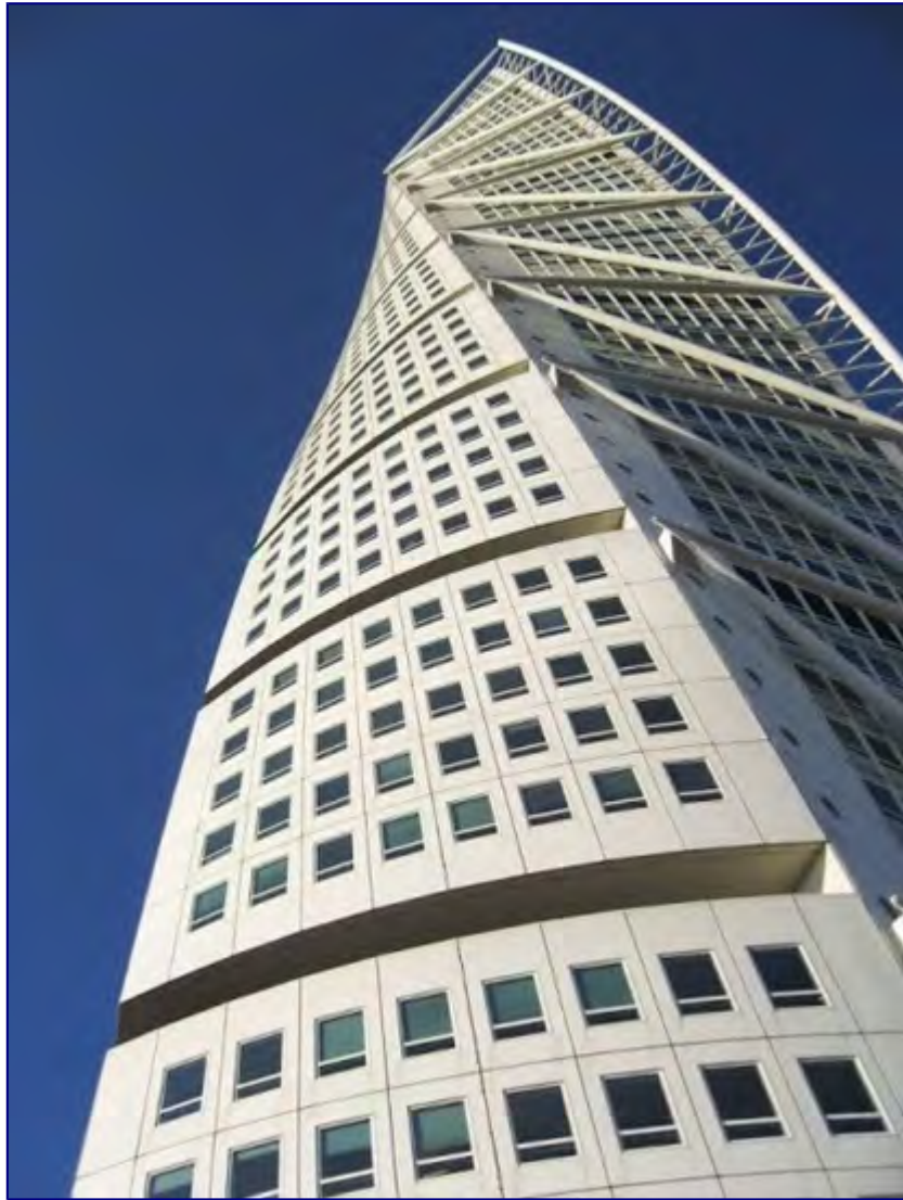
每层都是由一个不规则的五边形钢框结构围绕中轴旋转构成
