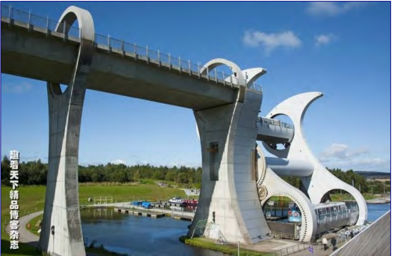
英国苏格兰，法尔柯克水轮的庞大建筑被称为水上电梯丝毫不为过。作为世界第一个旋转式船舶吊桥，2002年5月24日，它由英女王揭幕正式落成。
