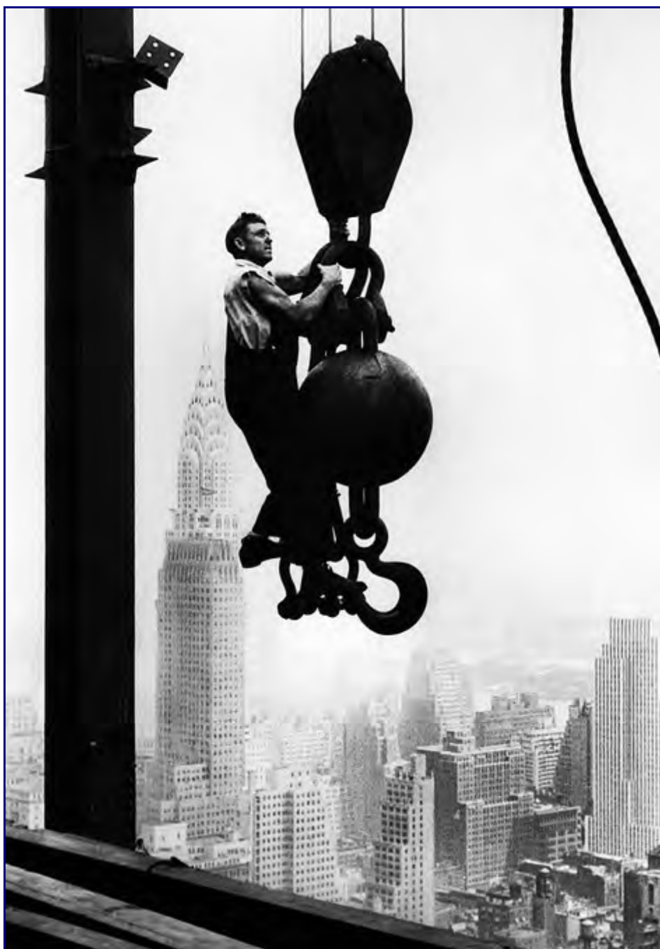
建筑工人在帝国大厦的吊车上工作
