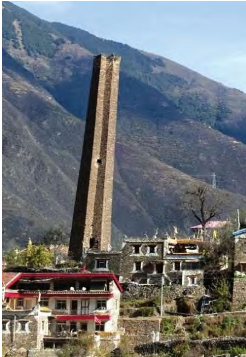
碉楼外呈八角形，由下往上成锥体形状，由石块和黄泥砌筑而成，整体高 43 米
