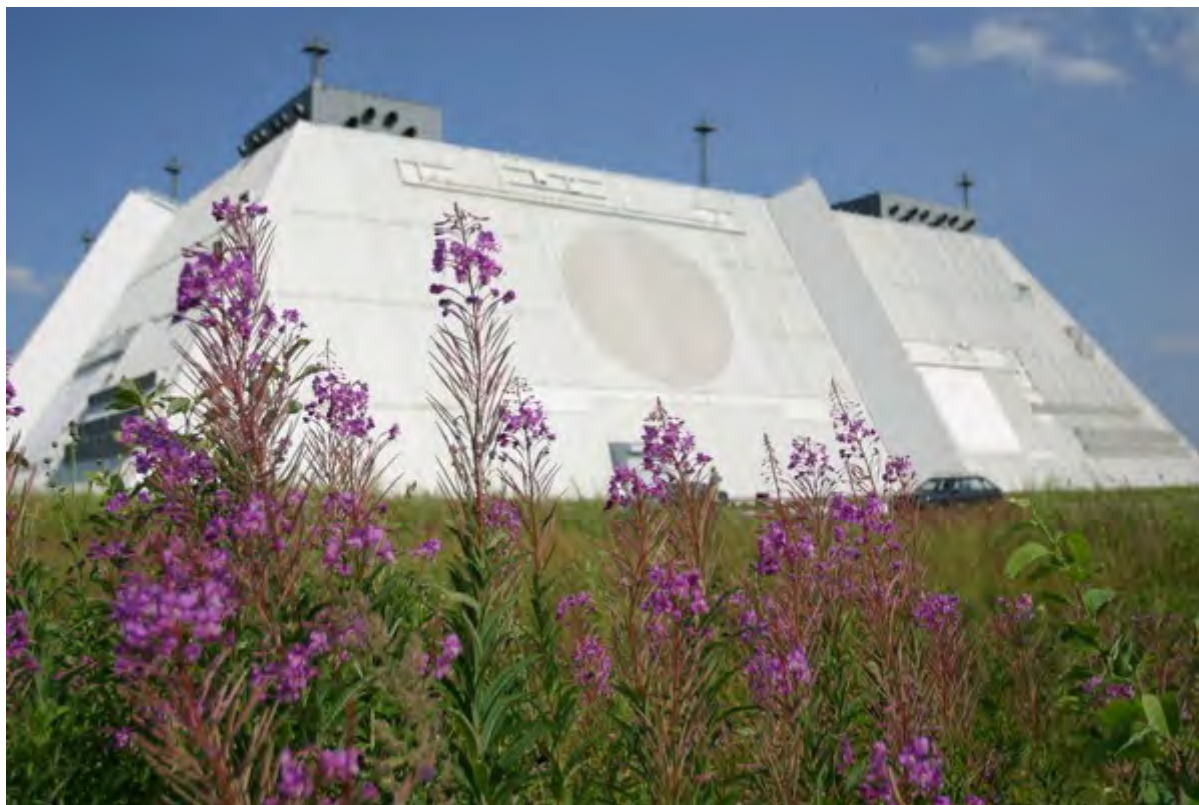
Don-2N 雷达是莫斯科反导系统的核心火控雷达，图中的圆形为其雷达阵面之一
