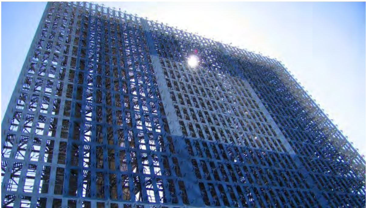
列克图西部署的第一部沃罗涅日 M 雷达，阵面由 3 个 10X30 米模块组成，它是俄罗斯战略预警系统复兴的开始
