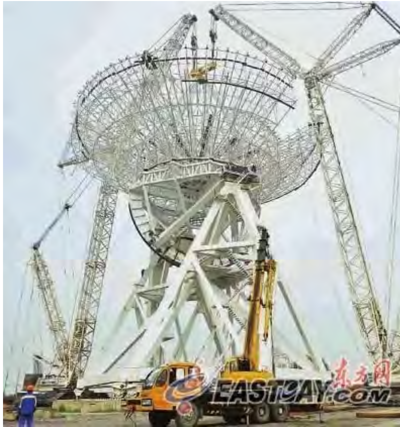
正在建设当中的射电望远镜
