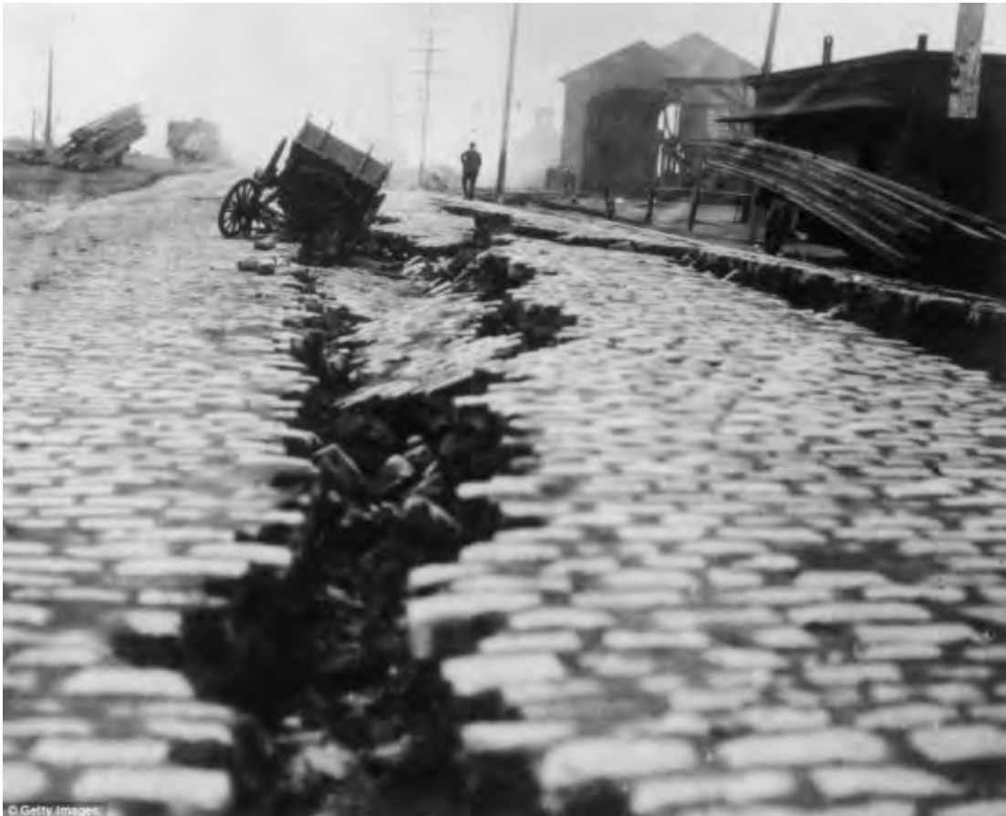
1906年，美国加利福尼亚州旧金山，大地震导致鹅卵石铺成的道路从中间裂开
