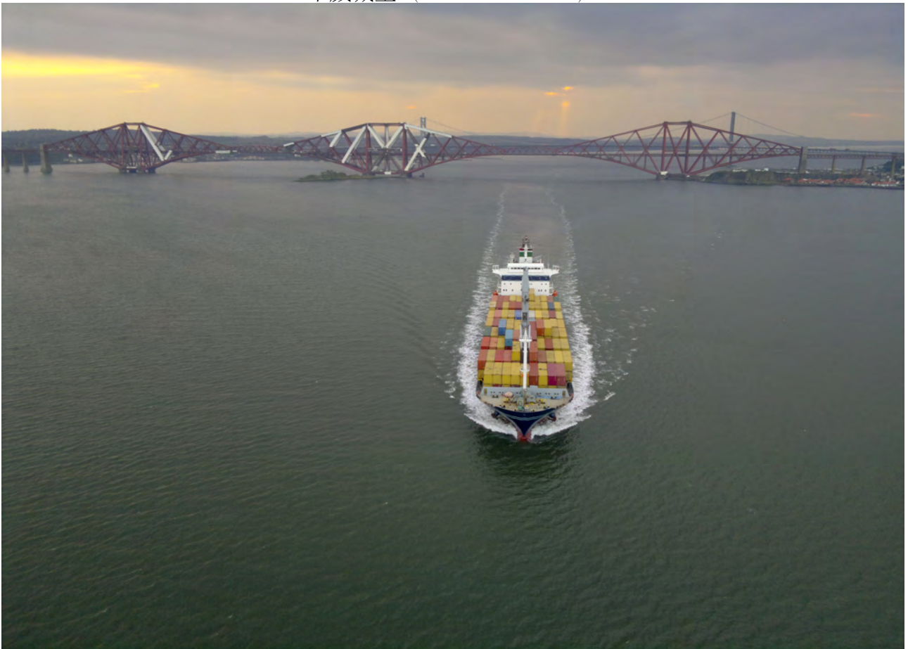
集装箱轮与福斯河 (Firth of Forth) 铁路桥
