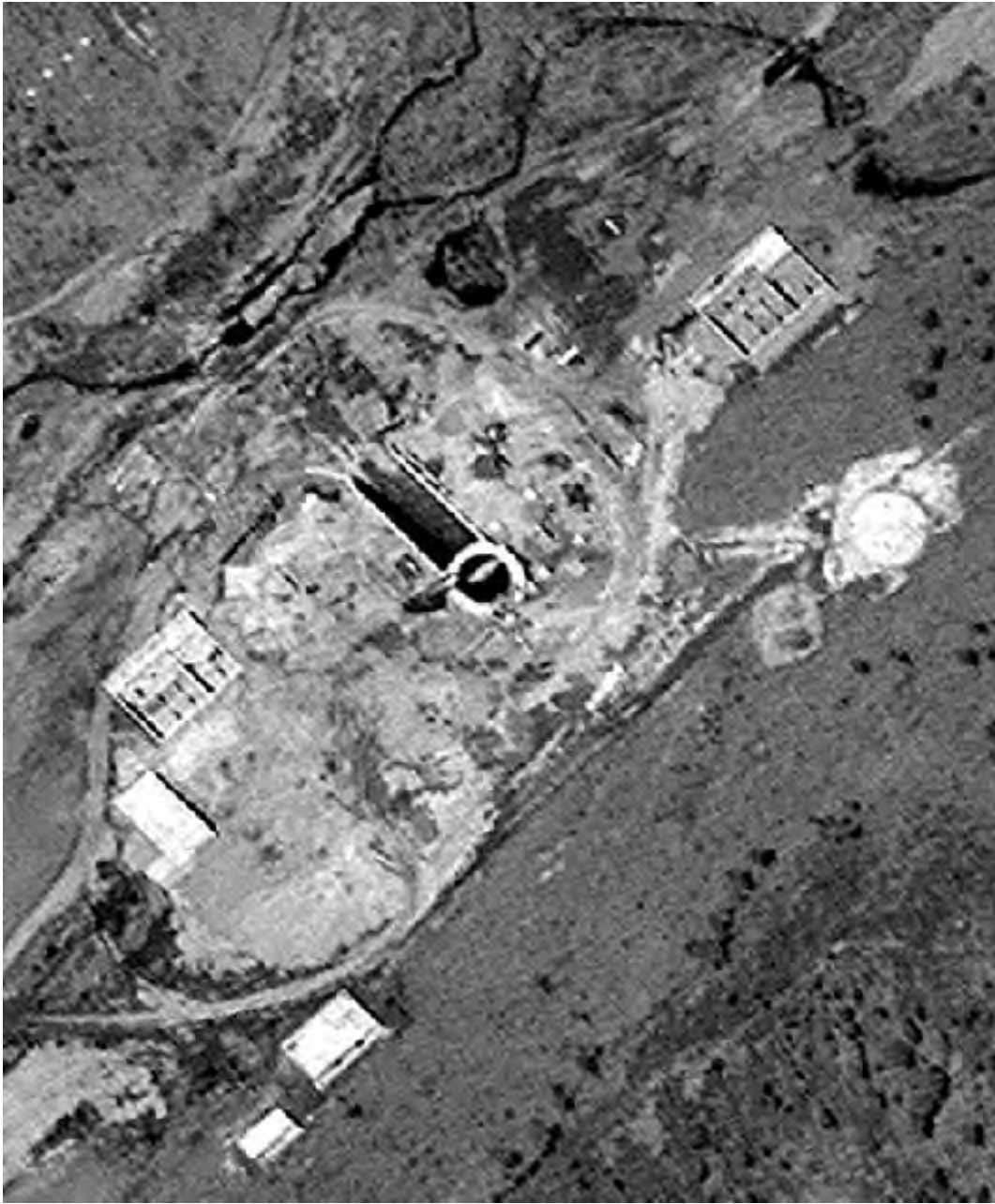
舞水端里发射场正在建设新的发射台
