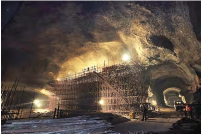
建设中的实验大厅。
