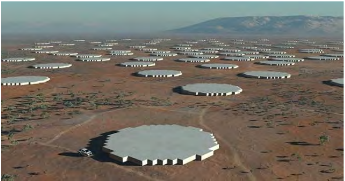
中频孔径阵列，可一次对多个太空区域进行观测
