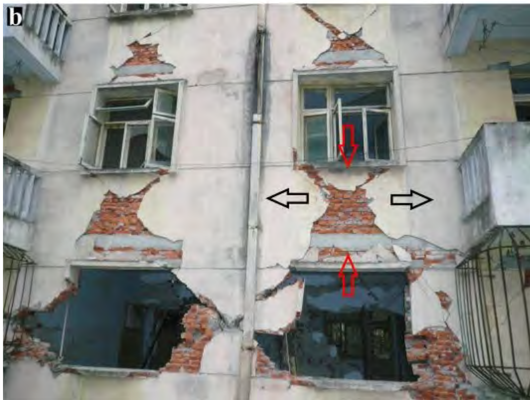
映秀漩口中学校舍墙上的X破裂，由汶川地震形成。该楼原为5层，一楼坐下去了，二楼压到地面。一楼屋内的人若没逃出必死无疑。
