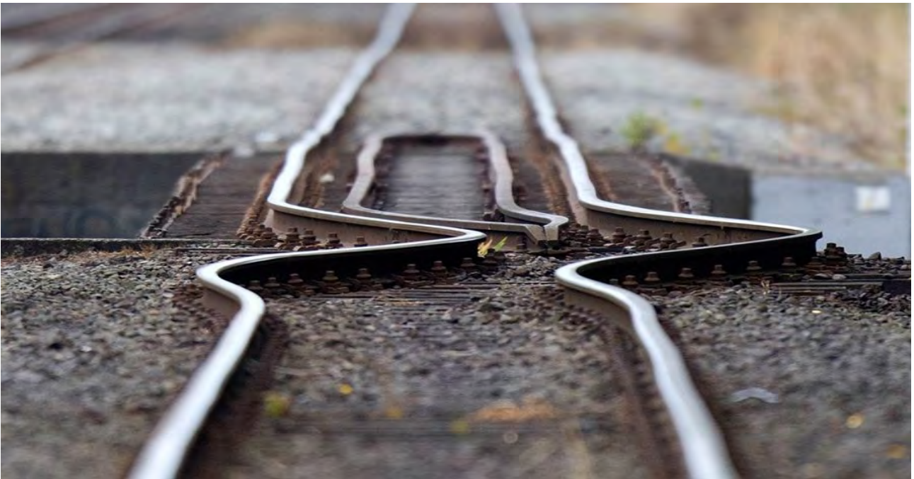
当地时间 2011 年 2 月 23 日，新西兰基督城，一段被地震扭曲的铁轨。2 月 22 日，新西兰发生 6.3 级地震。Marty Melville/摄
