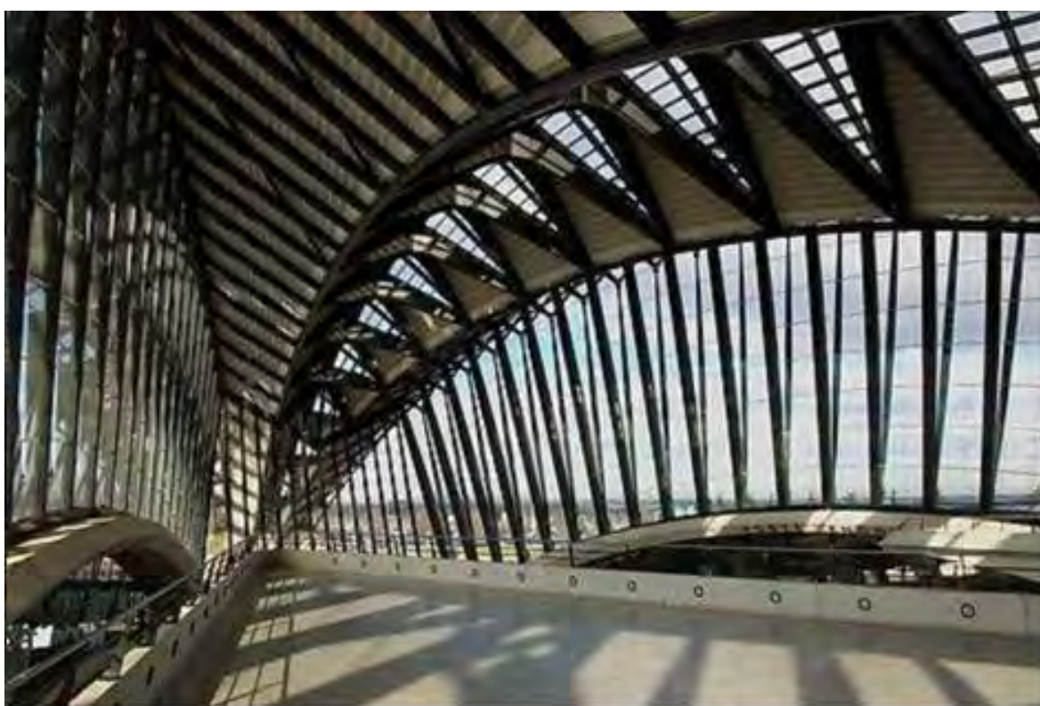
GARE ST. EXUPÉRY - LYON 聖.埃克蘇佩裏站
