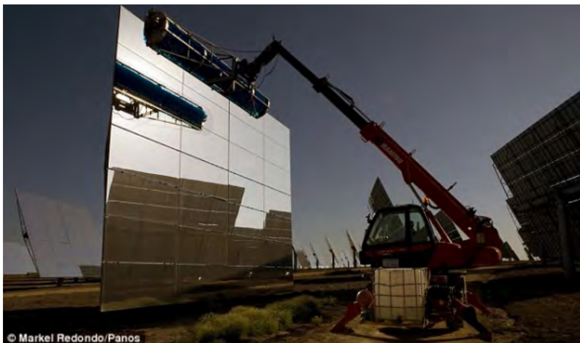
起重机举起日光反射镜，把它送到正确位置。
