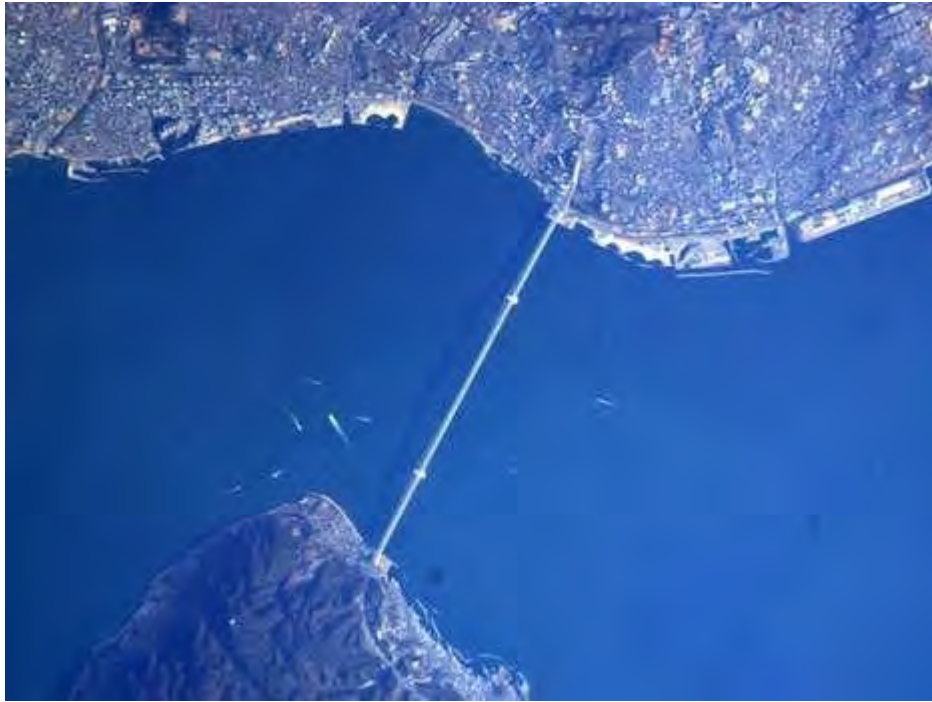
蓝色大海中的一条白线：这就是世界上最长的吊桥——明石海峡大桥
