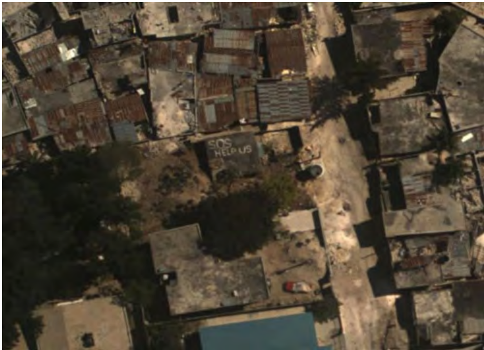
太子港高分辨率航空照片，可看到一个屋顶，写着“呼吁帮助”的大字。
