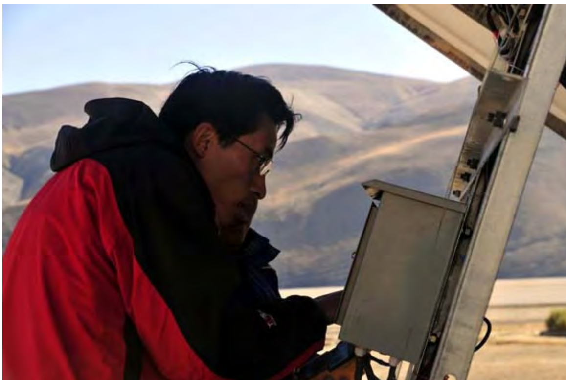
技术人员在珠峰地震台调试设备（10月17日摄）。新华社记者 颜圆圆 摄
