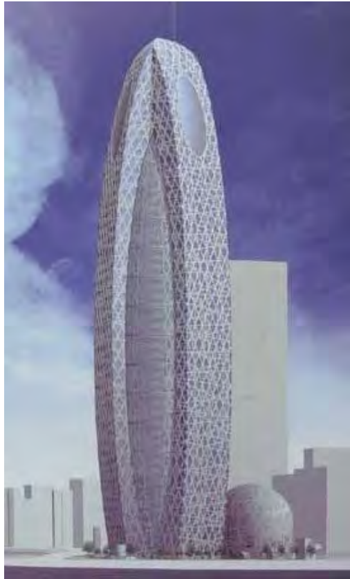
图 4：蚕茧大厦共两部分，分别由 50 层的塔楼和底部 6 层圆形商业会展大厅组成。
