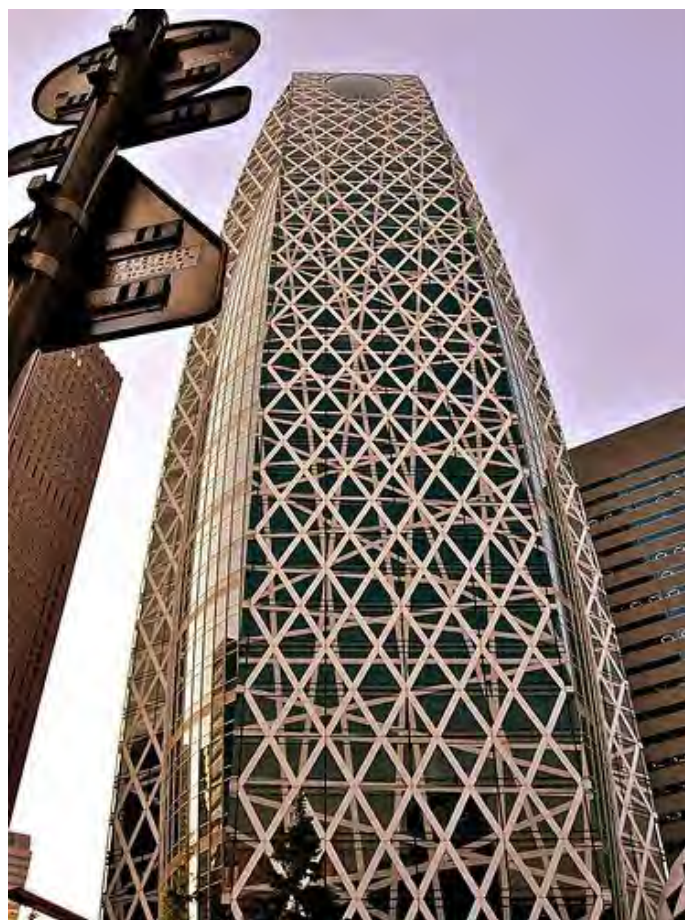
图 5: 塔楼主体框架是钢铁斜格结构
