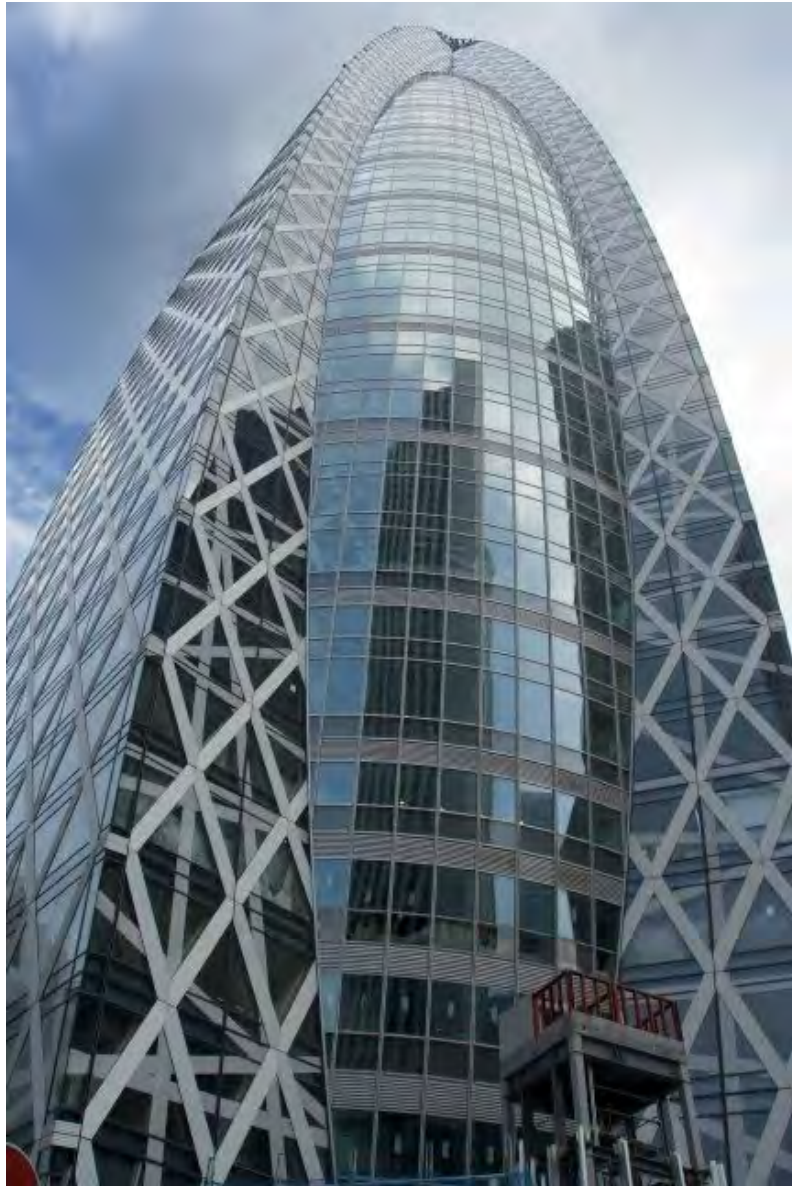
图 3: 以独特的造型结构吸引分解外来冲击力，从而保障自身的稳固性
