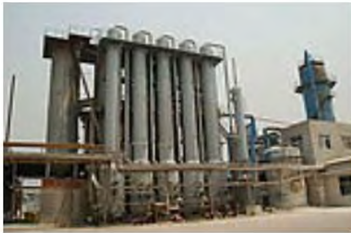
化工厂的管道
