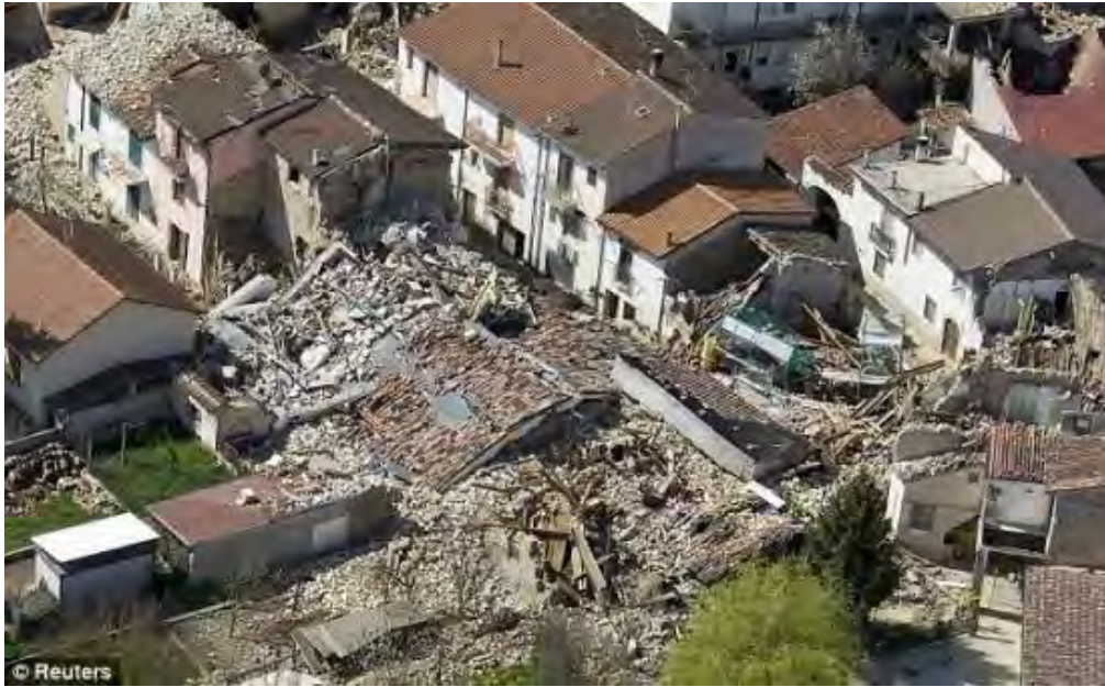
意大利地震导致大量房屋倒塌
