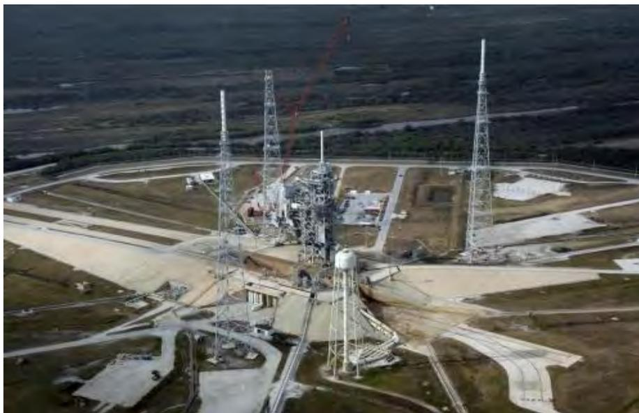
对佛罗里达州美宇航局肯尼迪航天中心 39B 发射台新建防雷击高塔的鸟瞰图。左右两侧的两个高塔顶部有一个防雷击桅杆，中间一个高塔则没有。位于中央的是固定和旋转服务结构，以前用于航天飞机项目。最显眼的地方是一座可装 30 万加仑水的高塔，在航天飞机发射期间用以压抑震耳欲聋的噪音。
