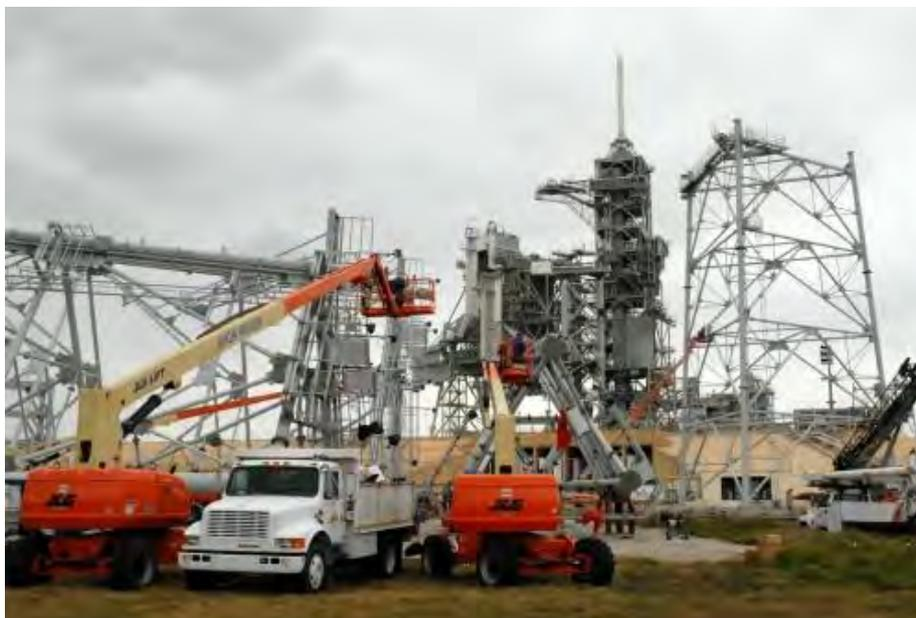
2008年11月25日，位于佛罗里达州的美宇航局肯尼迪航天中心39B发射台，吊车正准备将设备吊到新防雷击高塔上。这三个高塔每个高500英尺，顶部还各有一个100英尺高的玻璃纤维桅杆，支撑一套重要的电线系统。这套经过改善的防雷击系统可以为高度堪比航天飞机的战神1号火箭提供更多的安全保护。B发射台是战神火箭首次发射的地方。
