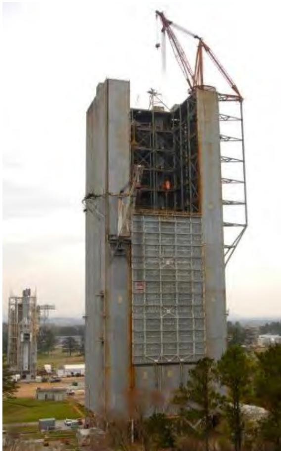
2008年3月，美宇航局工程师开始对马歇尔太空飞行中心的动态试验大楼进行大规模整修，将楼顶拆除，降低144英尺高、71吨重的大门高度。飞行中心眼下正在对这个试验大楼进行安全升级，对一台200吨转臂起重机进行大修，安装新的电力系统，希望在2011年7月对战神火箭进行全面测试时，这个试验站能够恢复其在阿波罗时期的能力。测试项目估计用时1年左右。
