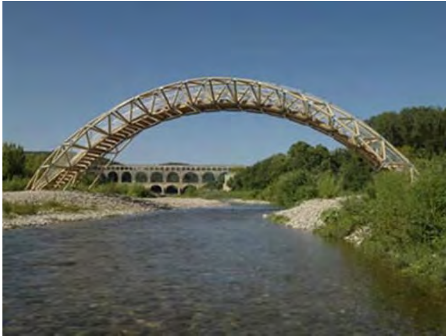
用硬纸筒建造的大桥
