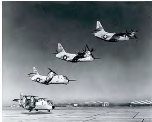
早期倾转机翼发展得最远的还要数 Vought Hiller Ryan 三家合作的 XC-142，美国军方对 XC-142 也寄予深望，空军、陆军和海军联合研制，这是又一个 Tri-Service 项目/XC-142 起飞到平飞的过程
