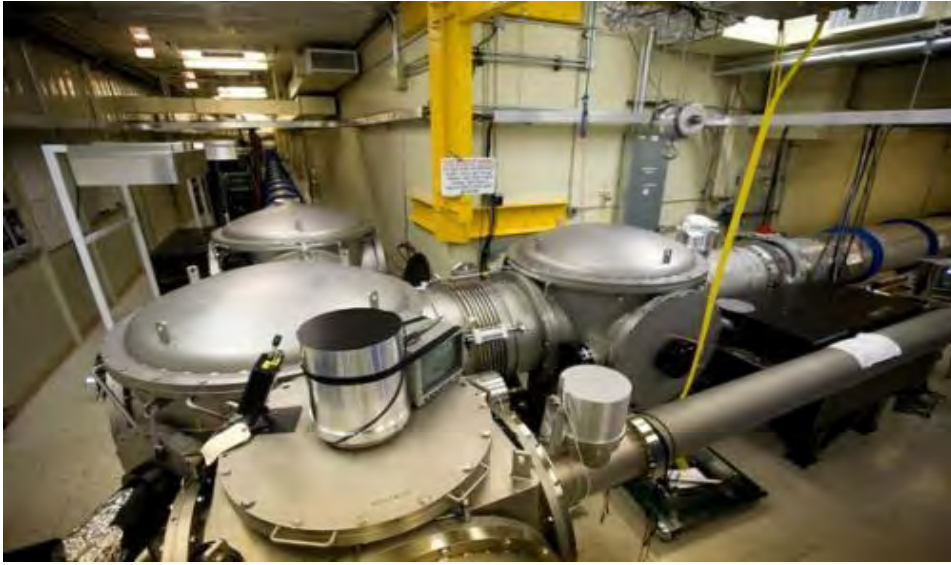
俯瞰干涉计顶部
